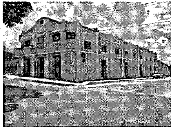
Atual Cine Pio XI recentemente reformado. Acervo: Deise Alves Eleutério
