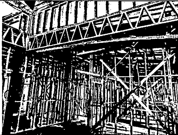
Descrição: Vista Interna
