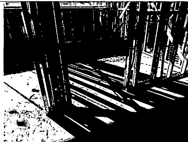
Descrição: Vista Interna - Piso
