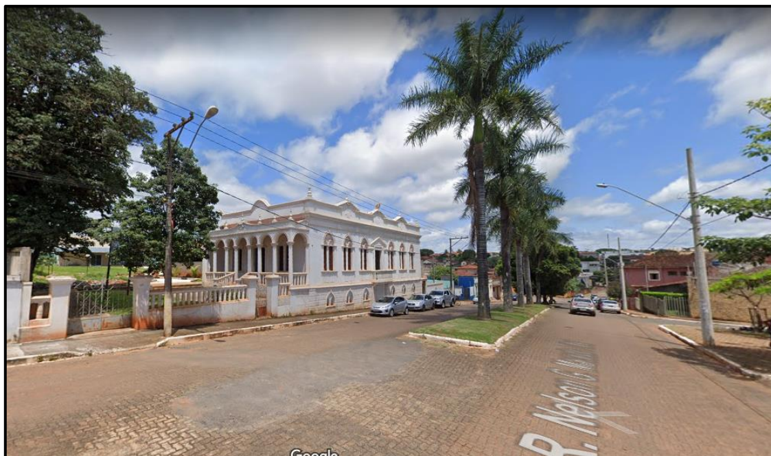
FIGURA 21: Fachada frontal e lateral direita da Casa Grande em 2018.
