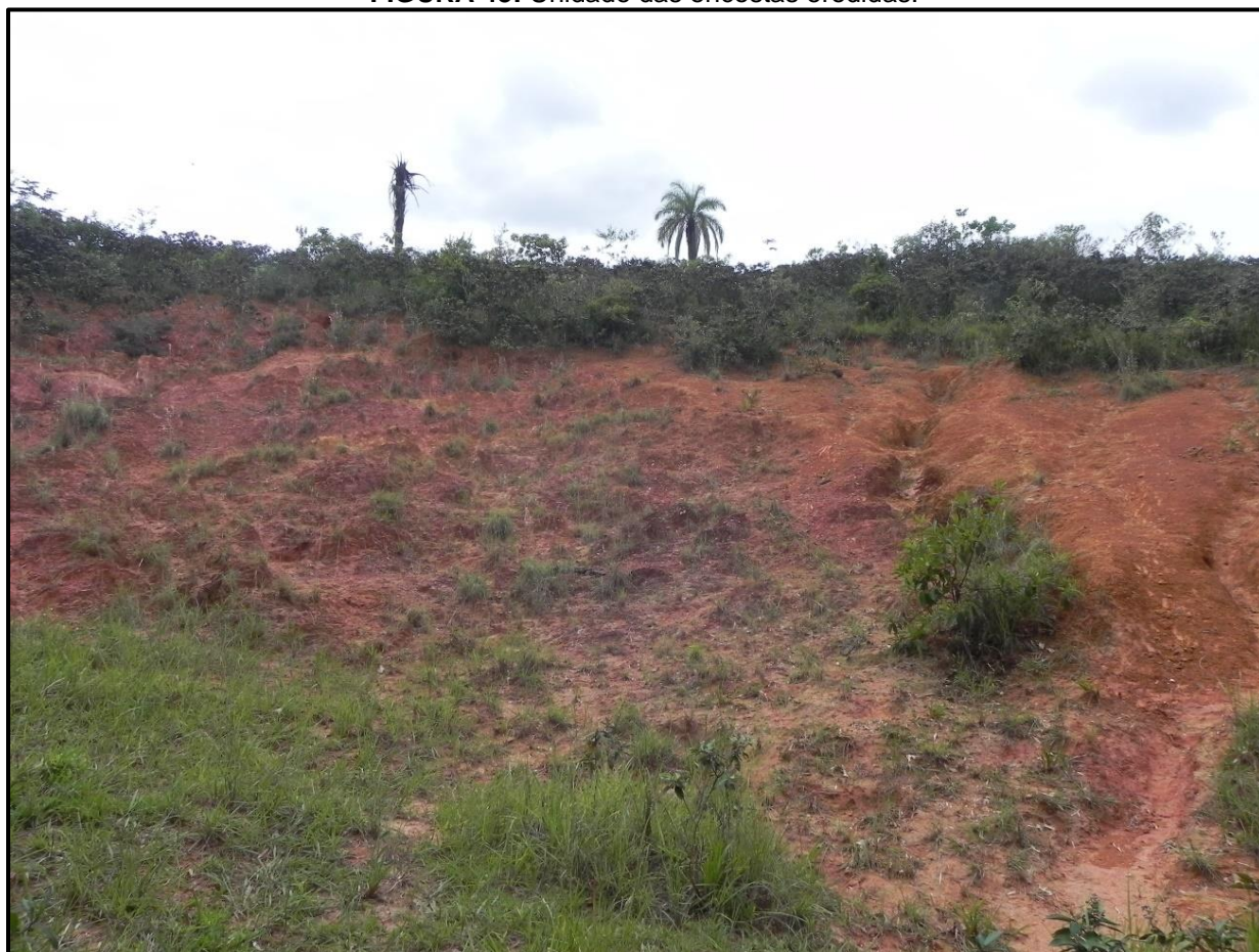
FIGURA 43: Unidade das encostas erodidas.
