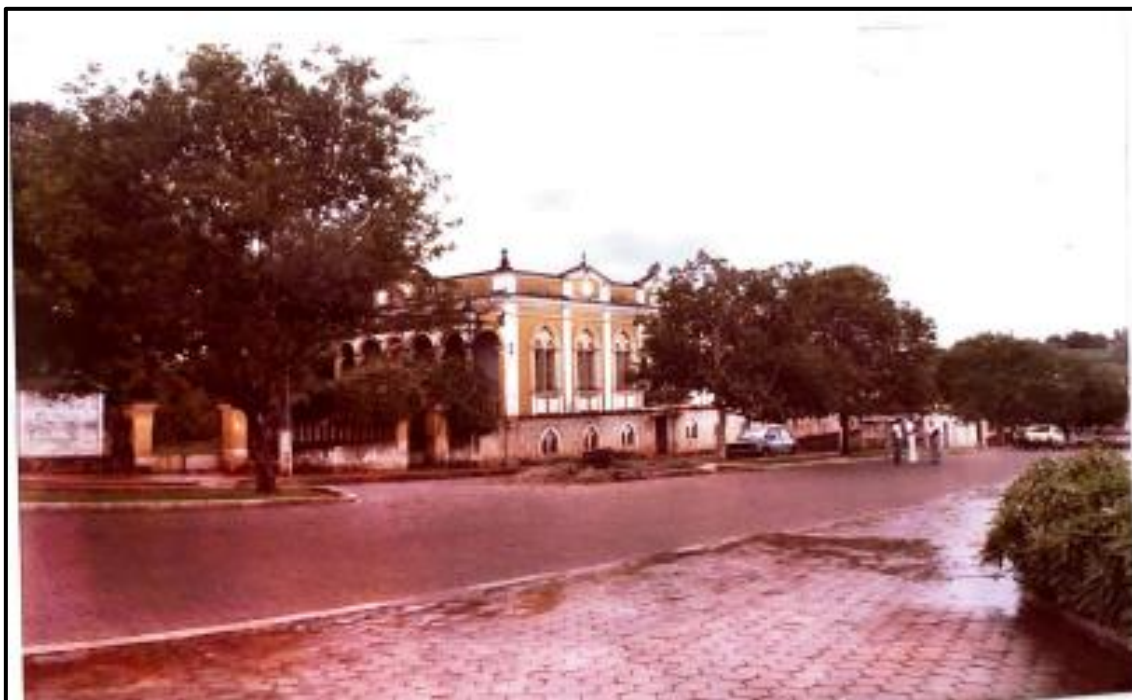
FIGURA 20: Fachada frontal e lateral direita da Casa Grande.
