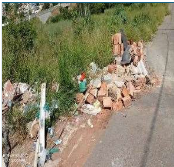
Figura 23 - Descarte irregular de RCC em Nova Serrana
