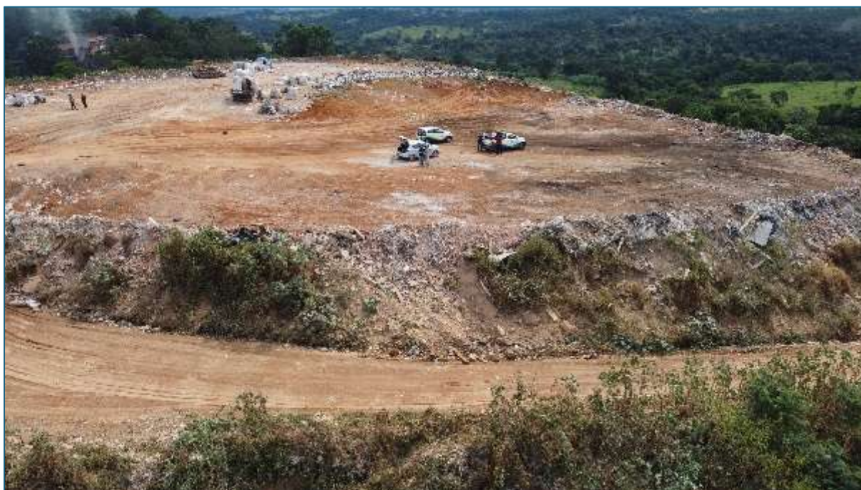
Figura 35 - Aterro Controlado de Bom Despacho
