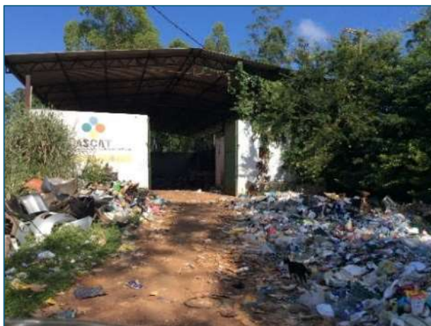
Figura 75 - Galpão de triagem
