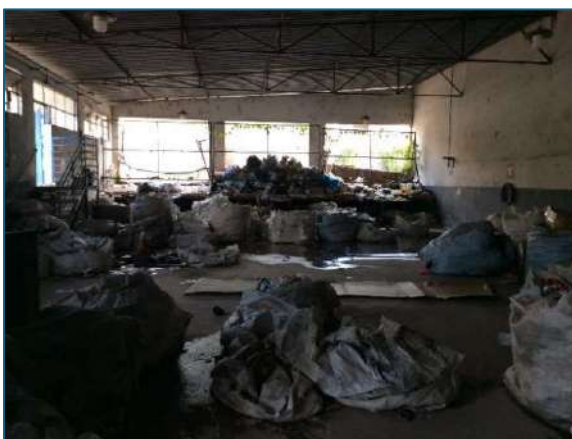
Figura 74 - Galpão de triagem
