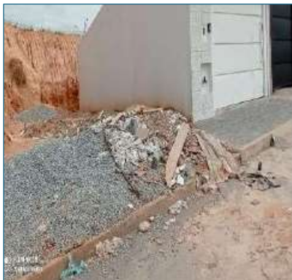
Figura 24 - Descarte irregular de RCC em Nova Serrana
