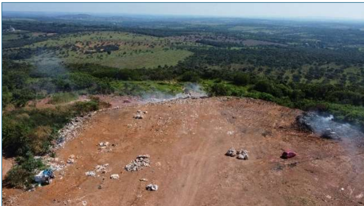
Figura 49 - Aterro Controlado de Pitangui
