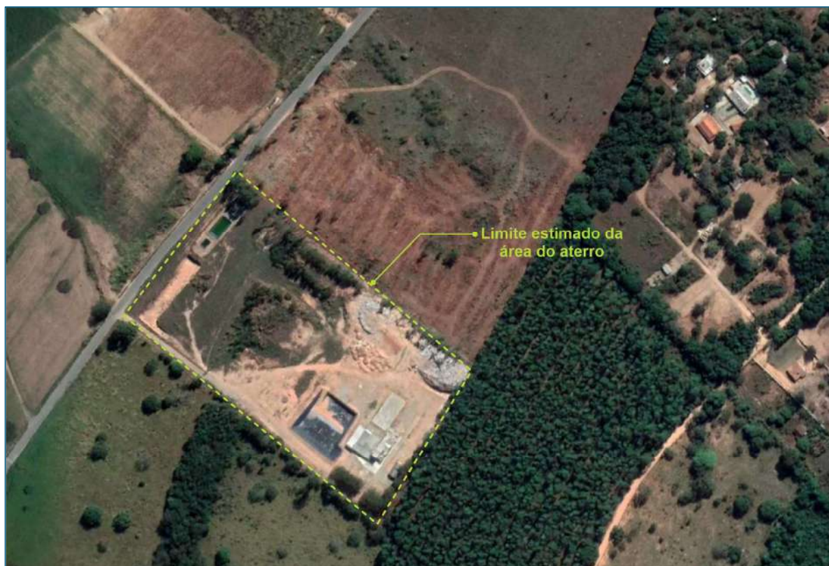
Figura 48 - Aterro Controlado de Perdigão
